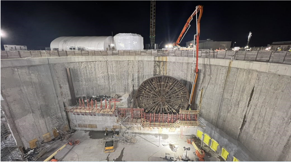
◀ South Island Concrete placement for headwall pour
